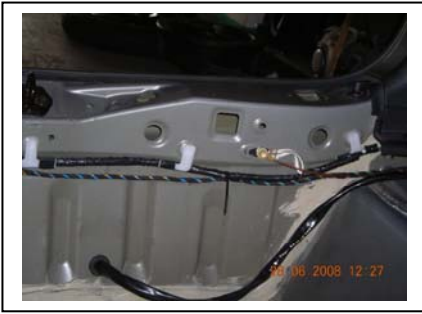
Verlegung Kabelstrang Kofferraum
